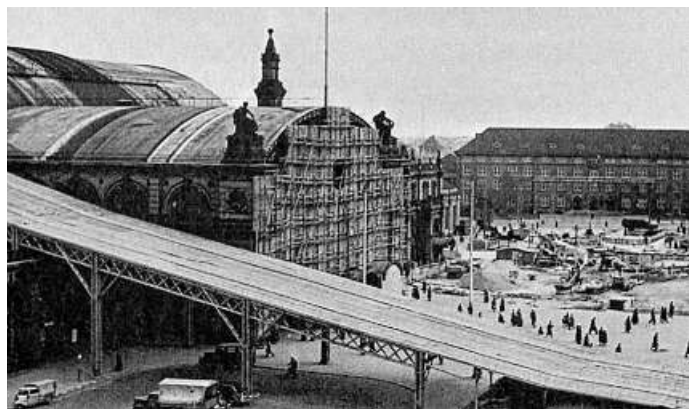
Auf dem Foto ist im Hintergrund der Bau des Tiefbunkers vor dem Bremer Hauptbahnhof zu erkennen.
